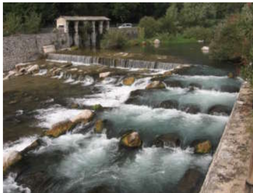
Illustrazione 5 - Briglia in località Malapreda (Arco) su cui è stata realizzata una rampa di risalita per i pesci.
